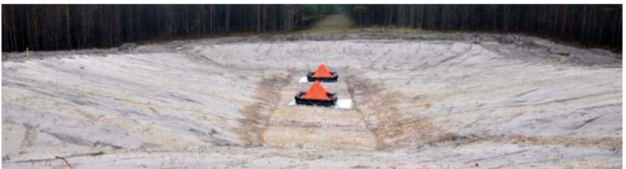
Abbildung 4: Großschurf zur Kippenerkundung auf der Innenkippe Schlabendorf-Süd (Rettungsinseln auf der Schurfsohle dienen der Sicherheit der vor Ort arbeitenden Personen bei der Probenahme) [3]
