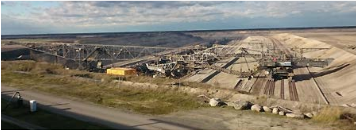
Abbildung 2: Abraumförderbrücke vom Typ F 60 [2]
