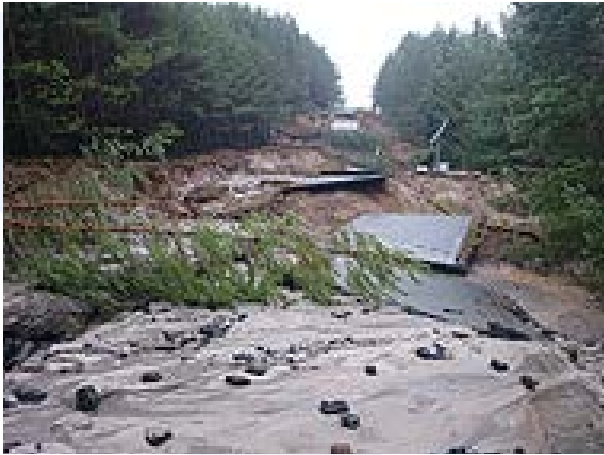
Abbildung 3: Bodenverflüssigung im ehemaligen Tagebau Schlabendorf-Süd [2]
